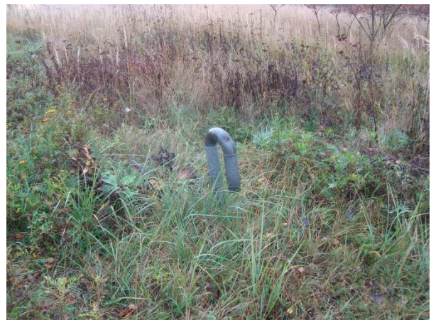
Abb. 3: Deponie Großhennersdorf. Links: Deponieoberfläche in jetziger Ausbildung. Rechts: Gasbrunnen als Relikt. (Fotos: Bartholomäus)
